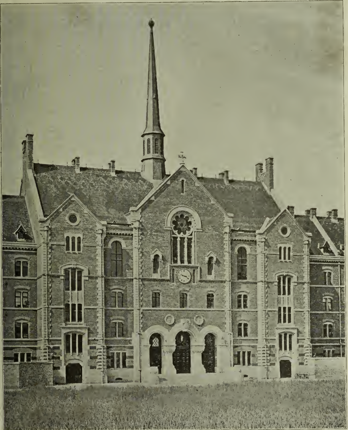
Johannis-Hospital in Leipzig. Ansicht des Mittelbaues von der Gartenseite. Erbaut 1871—72 durch Constantin Lipsius.
